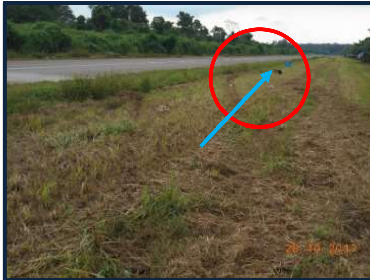
Fotografía No.: 11 Vista de la base de luz de pista arrancada.
