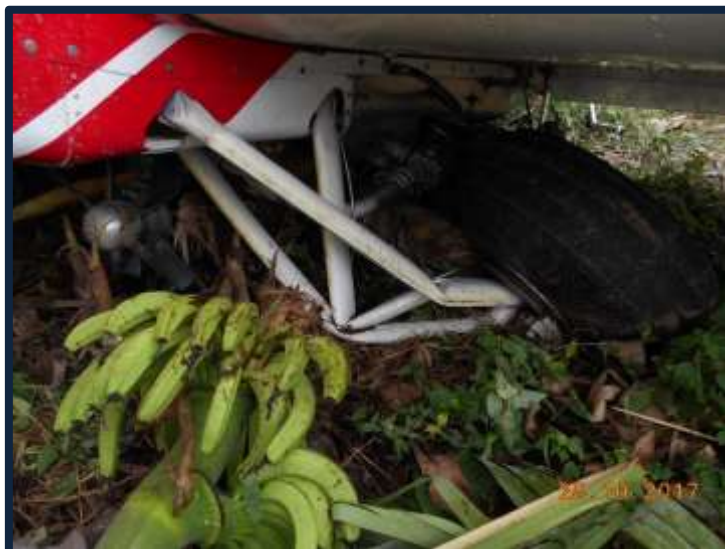
Fotografía No.: 4 Tren principal izquierdo dañado.
